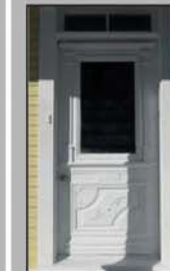
Porte en bois à panneaux et munie d'un carreau de verre dans la partie supérieur
