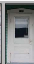
Porte en bois avec verre dans la moitié supérieure et chambranles autour des portes
