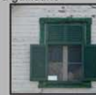
Fenêtres à battants à six carreaux et chambranles autour des fenêtres.
