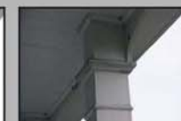
Aisseliers au sommet des colonnes
