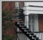
Garde-corps en fer forgé ou en bois à barreaux
