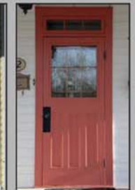
Porte en bois à panneaux et munie d'un carreau de verre dans la partie supérieur
