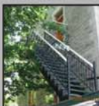
Garde-corps constitués de barreaux de bois ou de balustres Escalier
