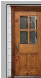
Porte en bois avec verre dans la moitié supérieure et chambranles autour des portes
