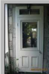
Porte en bois à panneaux et carreau de verre dans la partie supérieure
