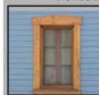
Fenêtres à battants à six carreaux et chambranles autour des fenêtres.
