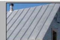
Tôle à baguettes
