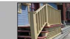
Galerie avec garde-corps et quelques marches y donnant accès
