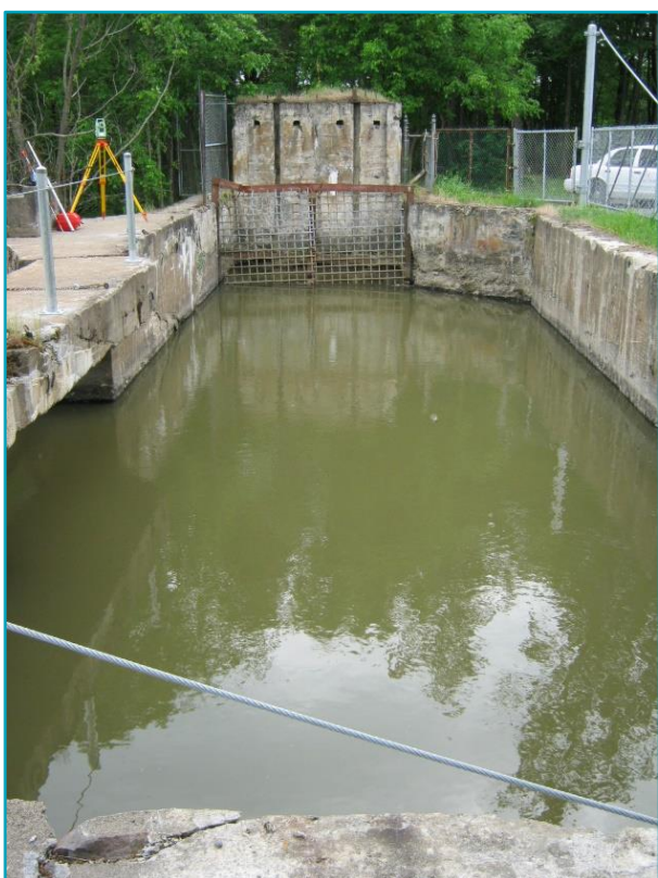
Figure 4. Vue du canal formé de murs de soutènement d'une hauteur de 3,65 mètres
