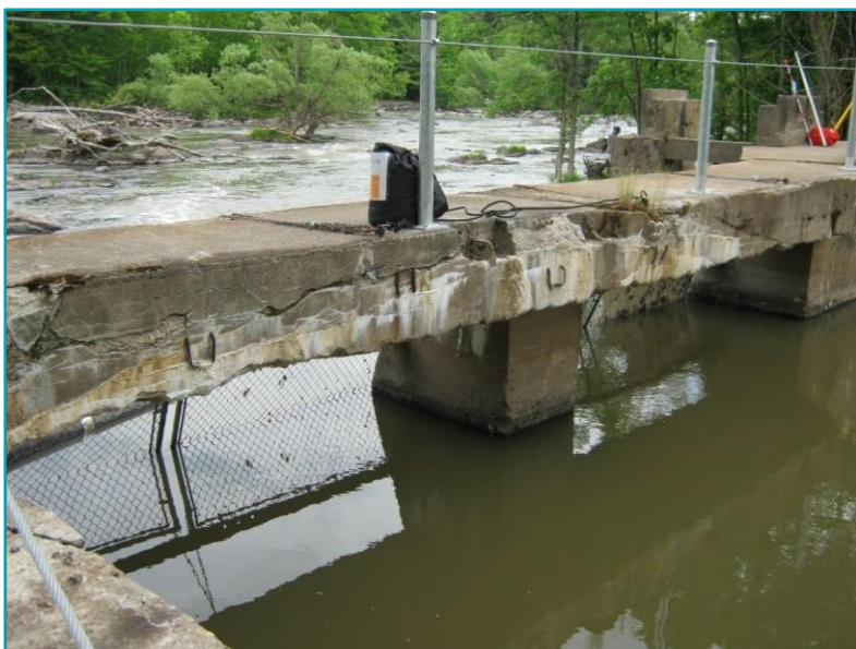
Figure 3. Vue des ouvertures du canal à partir de l'intérieur du canal
