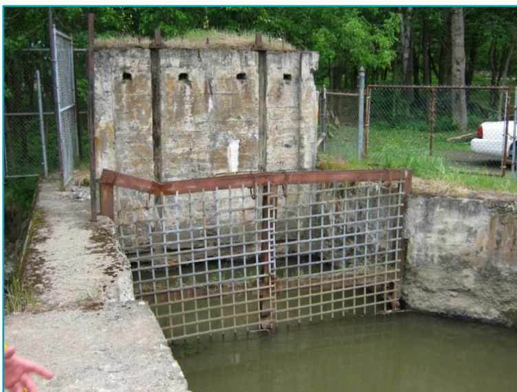
Figure 5. Vue de l'entrée du tunnel d'amener d'eau
