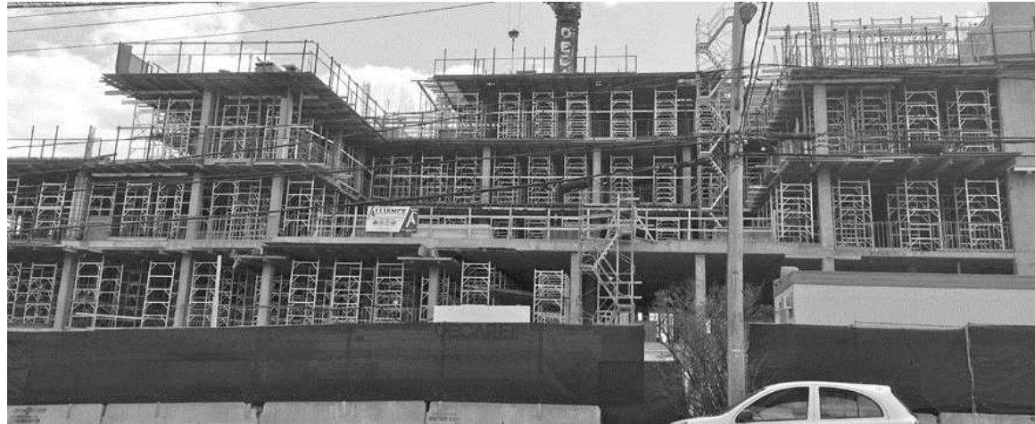
Pavillon de santé mentale en construction
