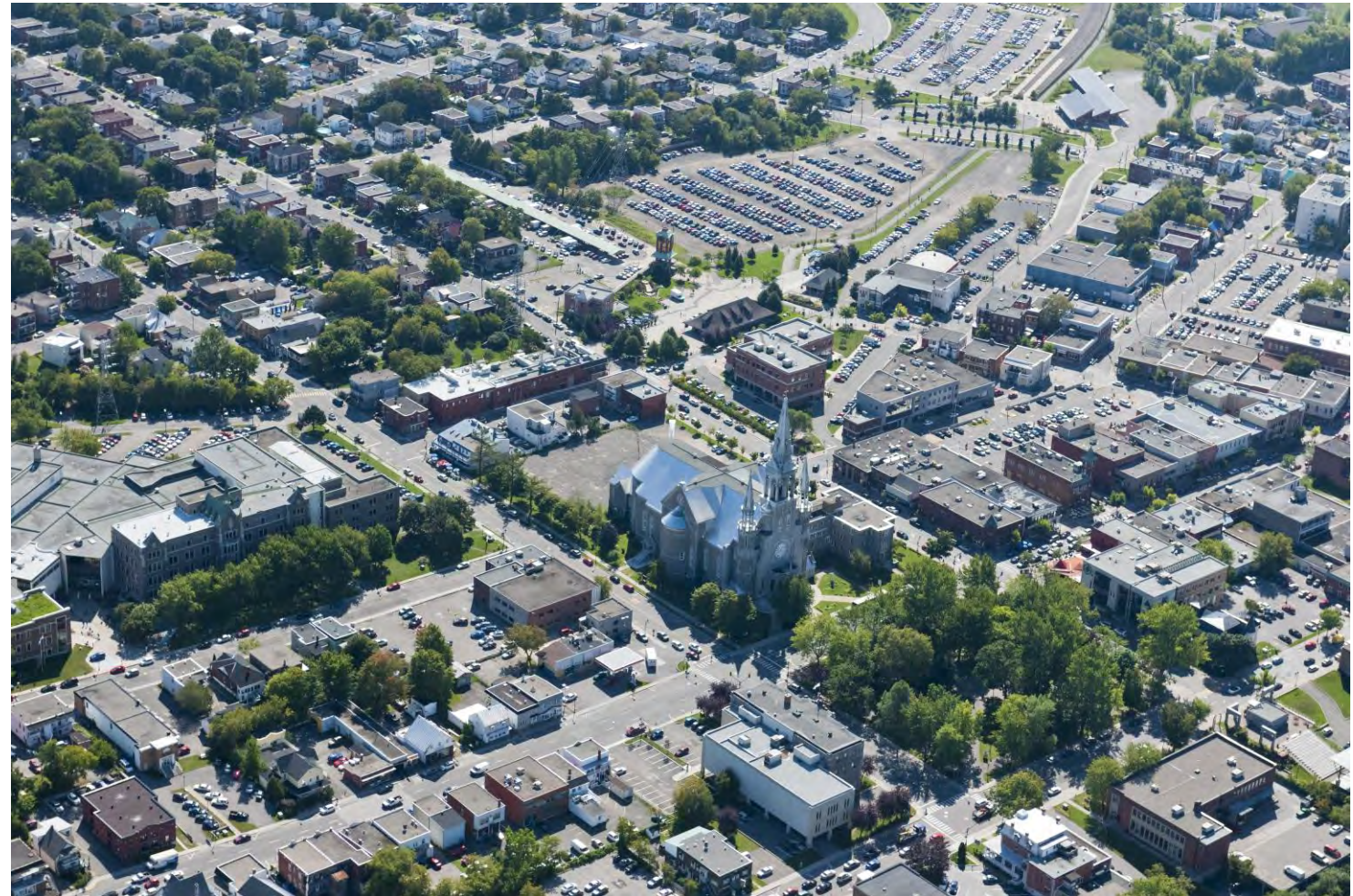
Illustration 12 – Vue aérienne du centre-ville de Saint-Jérôme
