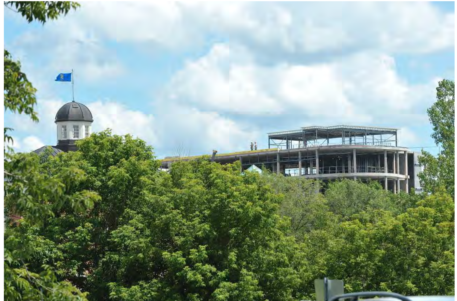
Illustration 31 – Construction de l'UQO, campus de Saint-Jérôme
