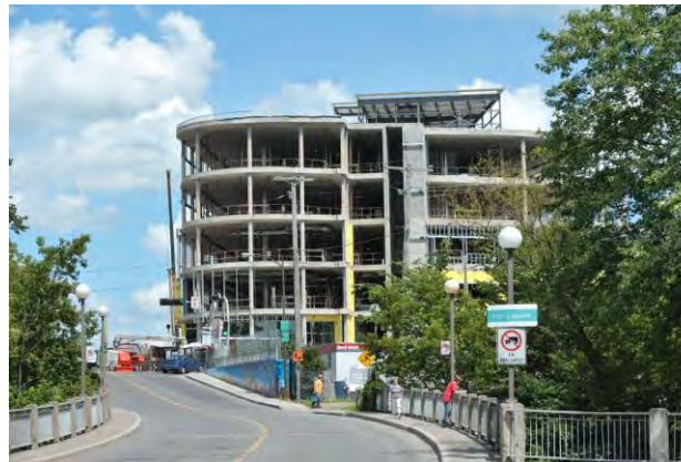
Illustration 26 – Construction de l'UQO, campus de Saint-Jérôme
