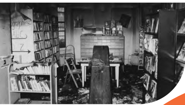
Dégâts causés par l'incendie, en 1985.
